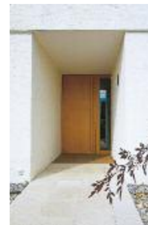
■ Reiner Kalkputz kam für die Fassadengestaltung zum Einsatz.
