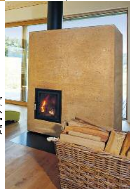
|| Lehm aus der Baugrube ist auch der Hauptbestandteil der Ofenhülle. Der Ofen wurde am Stück geliefert, wie die Stampflehmwand.
