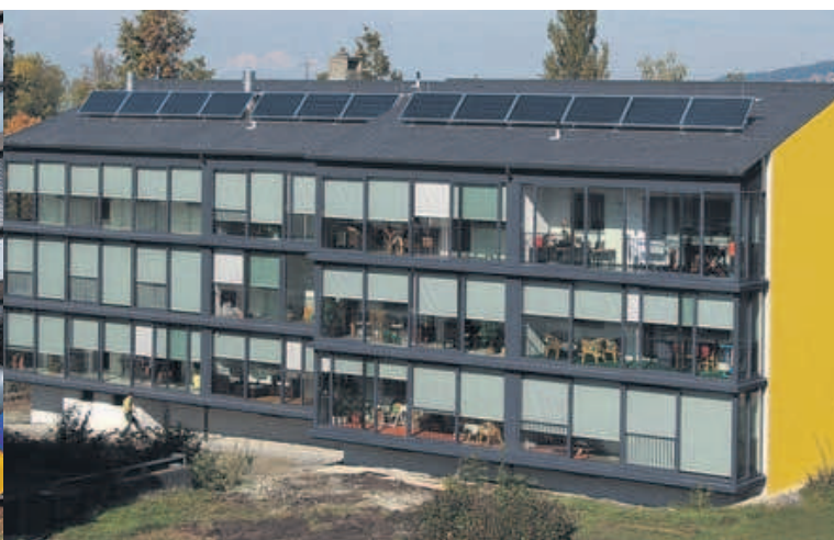
Auch in Dornbirn Fussenau steht ein beispielgebendes Mehrfamilienhaus.
